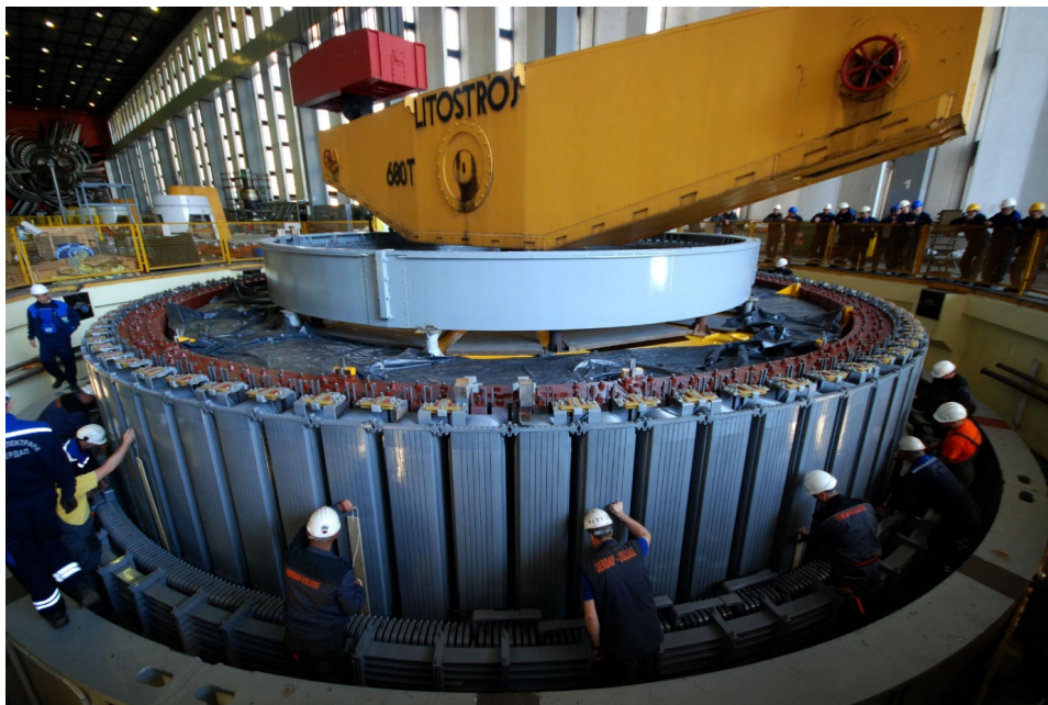
Slika 4.10. Završna montaža rotora sa istaknutim polovima u hidroelektrani Đerdap. Na rotoru se nalaze 84 polova.
